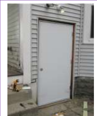
New Bulkhead Door
